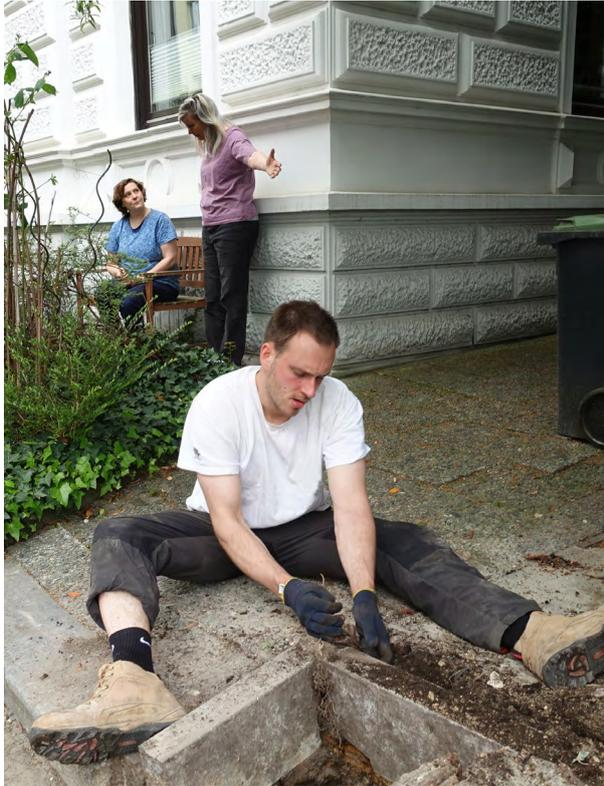
1 Ein Student entfernt die Wurzeln eines abgestorbenen Baumes, der das Fundament eines Ziegelpfeilers angegriffen hatte, so dass dieser einzustürzen drohte. Anmerkung der Autoren: Die Gesichter der Frauen im Hintergrund wurden mithilfe von KI und Bildbearbeitungsprogrammen anonymisiert.
